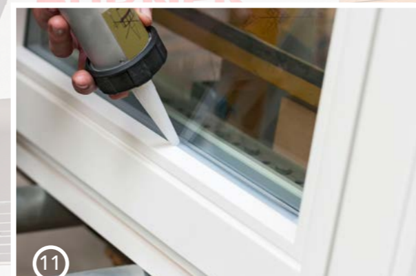
Versiegeln mit Hochleistungs-Silikon
